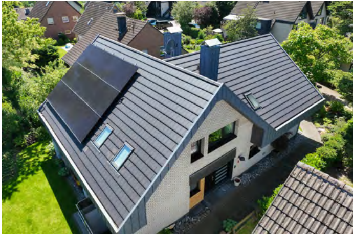
Ein saniertes Dach bietet zuverlässigen Schutz vor Extremwetterereignissen, dämmt gut und steigert den Wert der Immobilie. (Foto: HLC/ERLUS AG)
