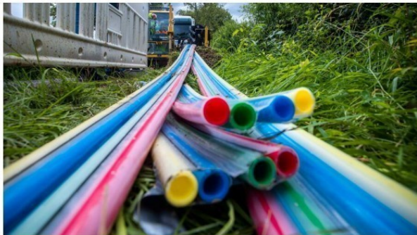
Leerrohre für das spätere Verlegen von Glasfaserkabeln
