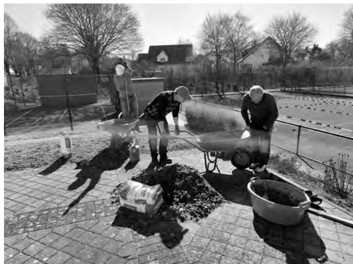
Die Fundamente für die neue Markise werden betoniert
