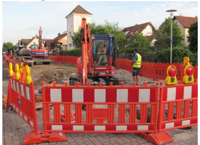
Mit den Arbeiten zur Sanierung der Wilhelmstraße wurde im August begonnen. Das Bild zeigt die Wilhelmstraße von der Kapellenstraße aus. Die Fahrbahndecke ist bereits teilweise entfernt. Am Anschlusspunkt des neuen Mischwasserkanals an den Kanal der Kapellenstraße erfolgten die Vorarbeiten für den neuen Anschluss.
