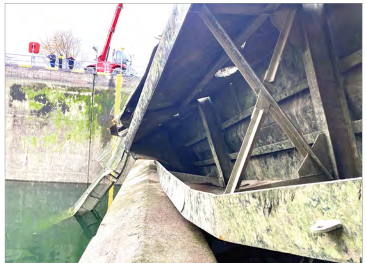
Vorarbeiten zum Rückbau des Obertores
